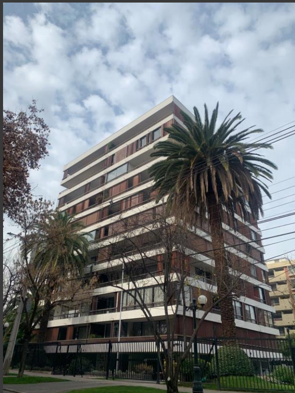
Comunidad Edificio Carmen Sylva, Providencia
